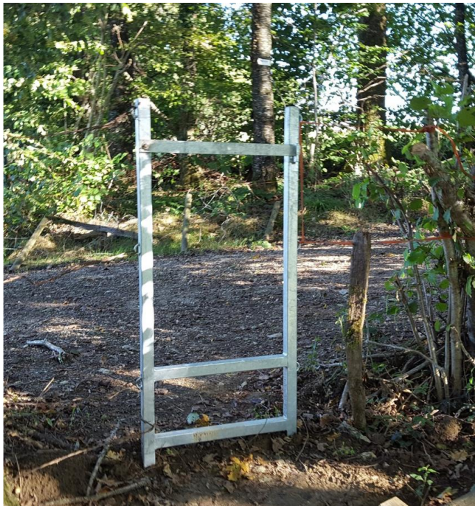
Les portes métalliques sont installées par les bénévoles du comité, avec l'accord des agriculteurs concernés. Photo DR
